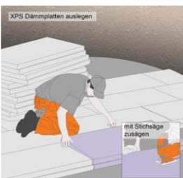
Optional: Legen Sie nun die XPS-Dämmplatten auf die Bodenplatte. Achten Sie darauf, dass diese nur einlagig, ohne Kreuzfugen und Stoß an Stoß verlegt werden sollten.
